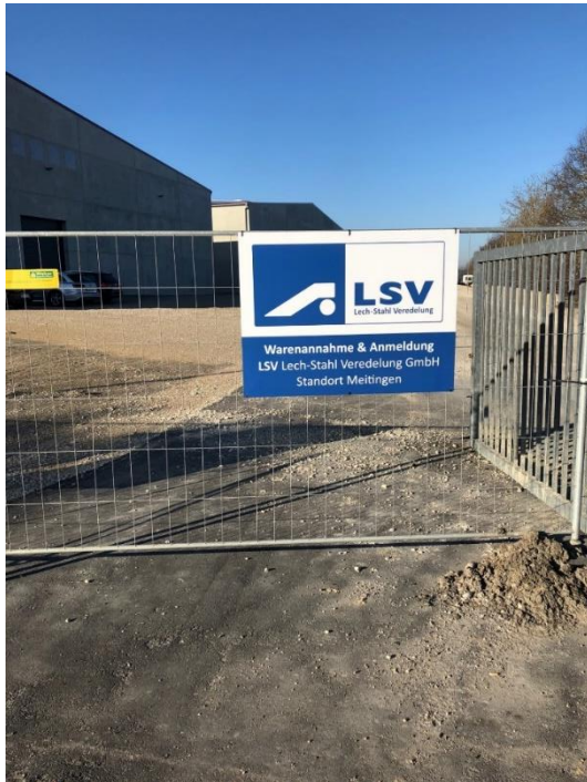
Image 2: Premier panneau de signalisation sur le chantier
